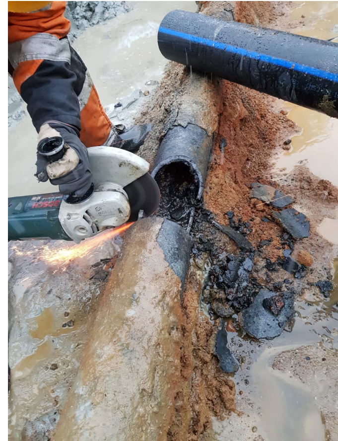
Kuvassa erään kunnan DN150-vesijohtoputki saneeraustyömaalla
